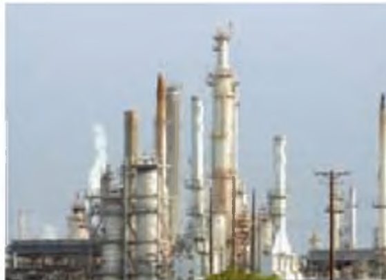
▲ Figura 25.9 Destilación fraccionada. El petróleo se separa en fracciones por destilación y se somete a un craqueo catalítico en una refinería, como la que se muestra en esta fotografía.
